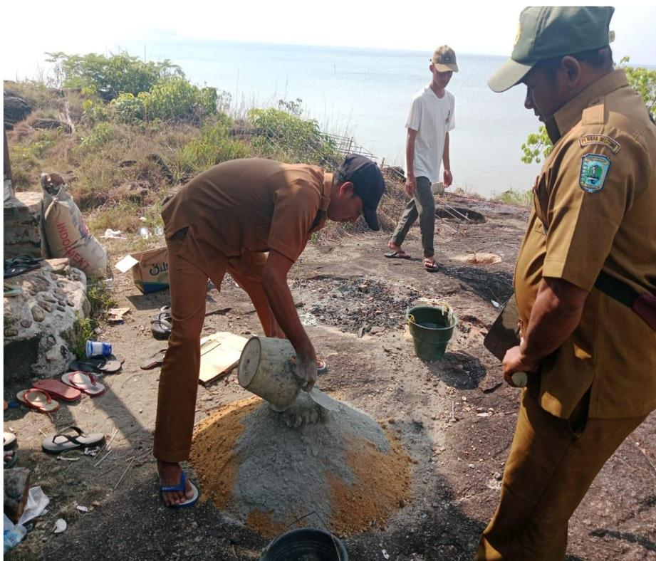
**Gambar 8. Proses pembuatan tugu nama Geosite Batu Bedil dari Ecobrick**
