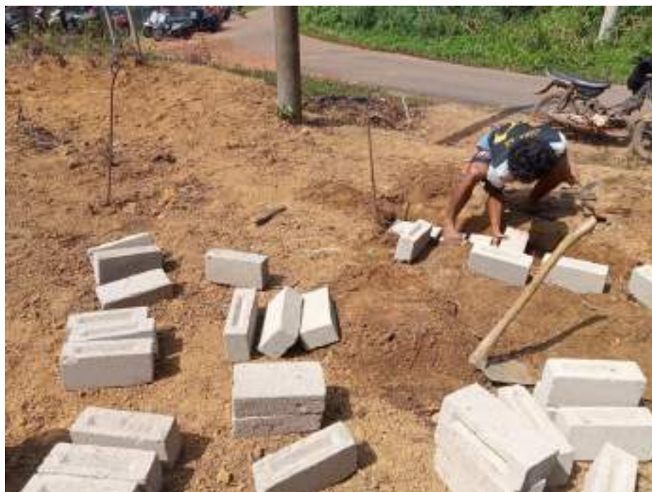
Gambar 1.11 Pembuatan pondasi ecobrick untuk hutan adat
